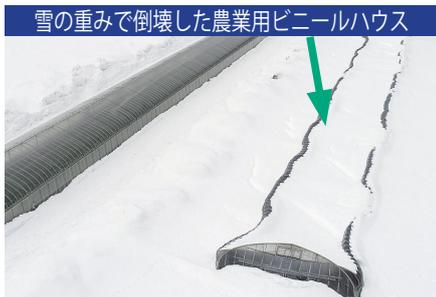
雪の重みで倒壊した農業用ビニールハウス
