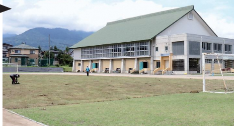
※作業後のグラウンドの様子
