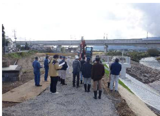
○瀬渡橋上流 樋管工事（上越市石沢地内）
