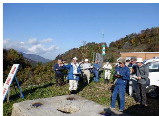
○矢代川第 4 号堰堤（上越市中郷区岡沢地内）
