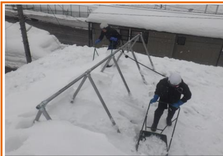
命綱固定アンカー使用例
