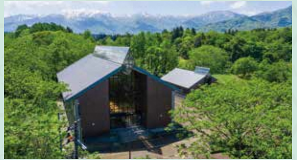
新井総合公園体育館
