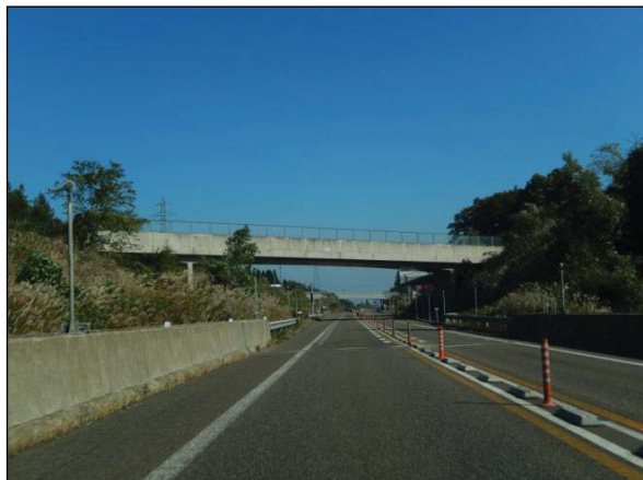
写真全景（コンクリート橋）
