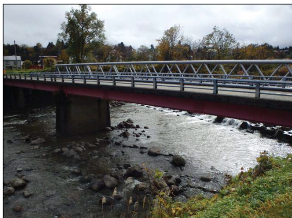
写真全景（鋼橋）
