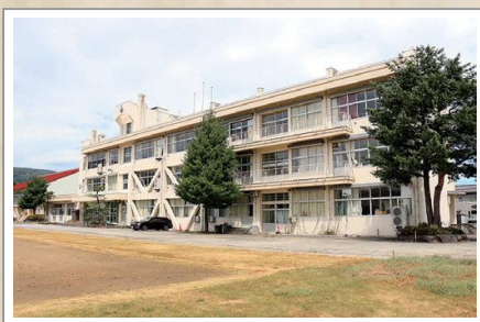
旧校舎の後ろ側に新校舎を建築。
