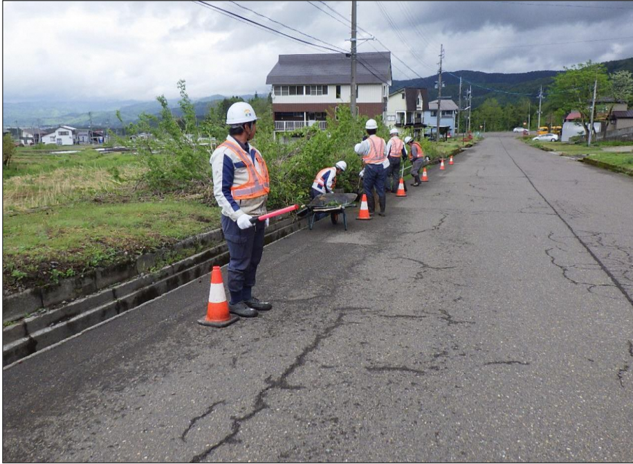
写真区分:環境整備 写真タイトル:側溝清掃 撮影年月日:2023年 5月 8日
