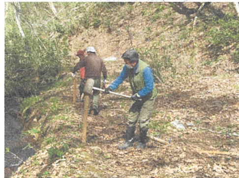
杭打ち作業 2 yuuho004
