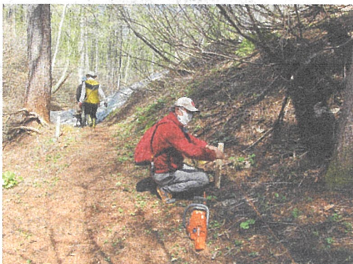
○ ロープ張り作業 3 yuuho005
