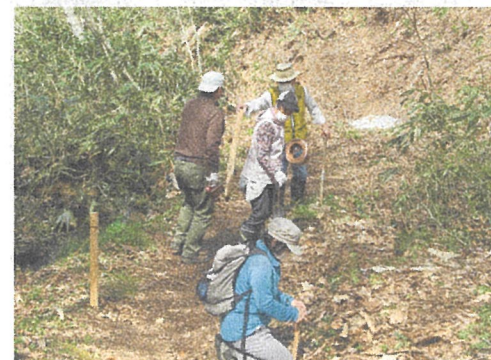
杭打ち作業ロープ張り 4 yuuho006
