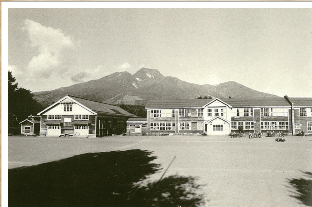
昭和 55 年撮影。旧校舎の建築年は不明。
