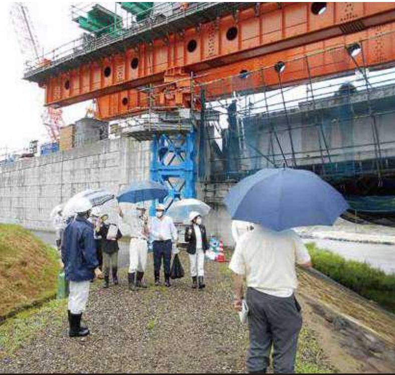
建設厚生委員会 〈瑞穂大橋工事現場視察〉
