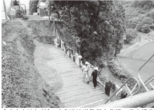
3密をさげながら、寸分道線道路災害復旧工事を視察
