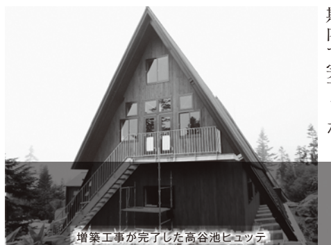
増築工事が完了した高谷池ヒュッテ
