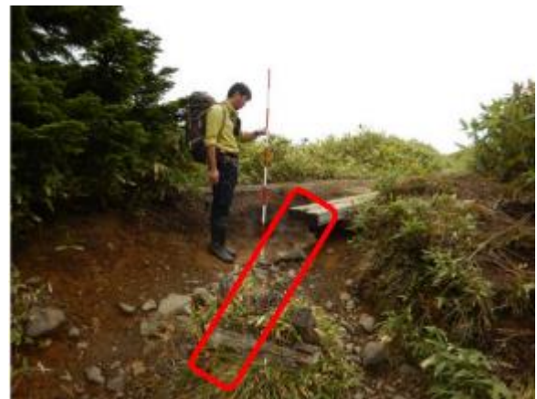
写真10 本道の消失による段差の発生
