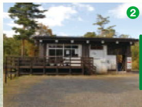
斐太県民休養地管理棟
