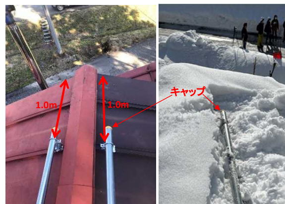
屋根端部を把握するため屋根端から1mの位置で単管を止める 単管端に付けた黄色いキャップが危険ゾーンの目印
