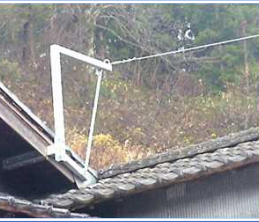
破風に金具を取り付け
