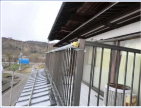
単管パイプを使用
