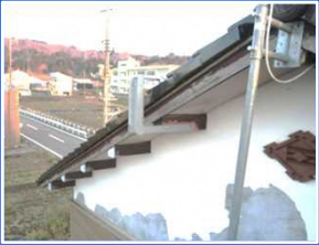
軒下の母屋に金具を取り付け、ワイヤーを張る
