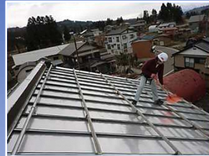
列状に単管パイプを配置
