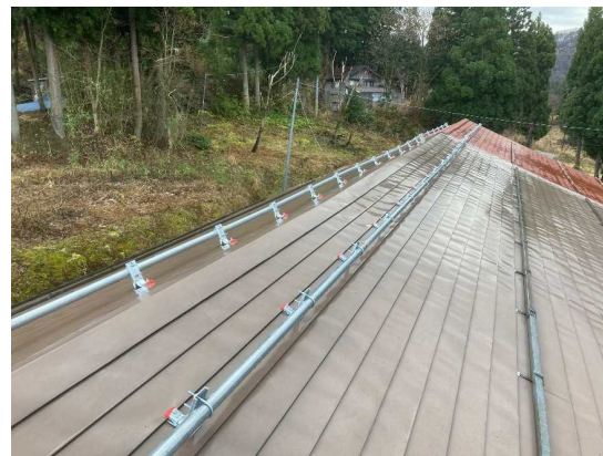
平葺き金属屋根に取付
