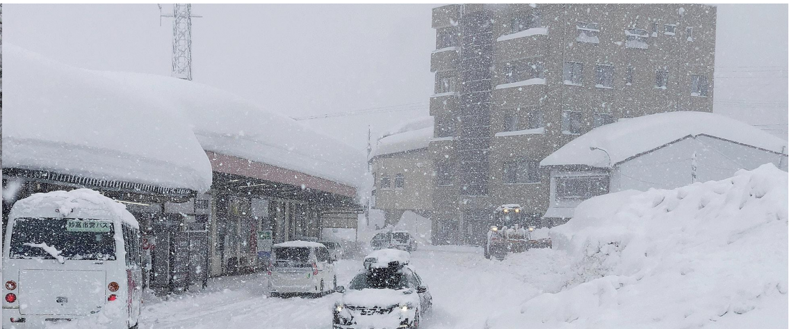
↑駅舎屋根には約2メートルの雪。駅前広場が緊急の堆雪場に（妙高高原駅付近）
