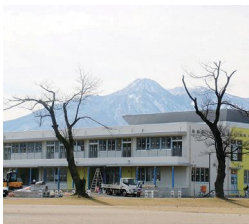
▲建設中の統合園 (令和3年11月30日撮影)
