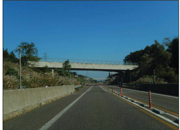
写真全景 (コンクリート橋)
