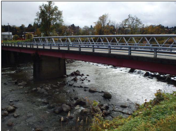
写真全景 (鋼橋)
