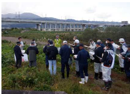
○瀬渡橋上流 樋管工事（上越市石沢地内）
