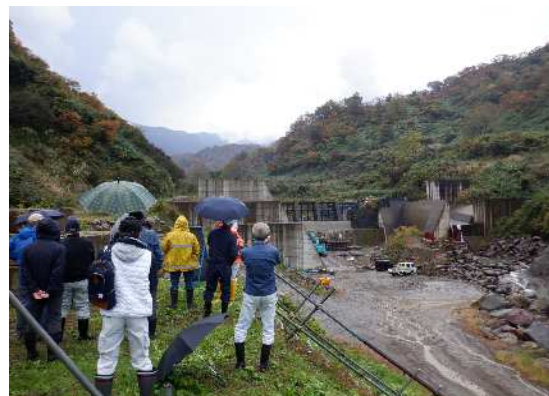
○矢代川第 4 号堰堤（上越市中郷区岡沢地内）
