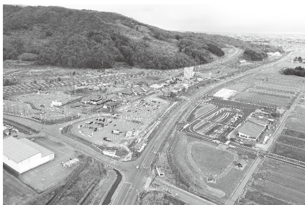
令和2年度拡張予定の道の駅あらい
