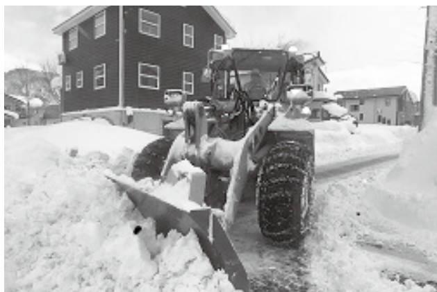
機械による除雪
