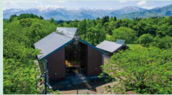
新井総合公園体育館
