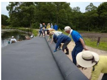
スイレン除去に向けた防草シートの敷設
